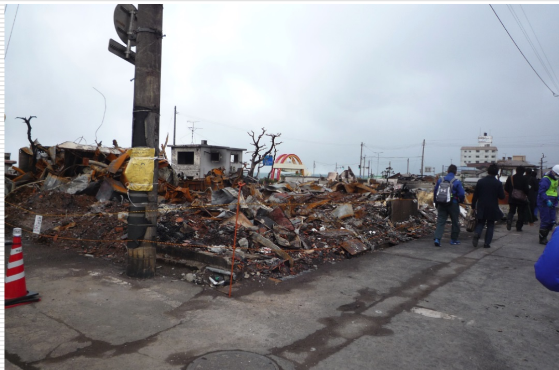
被害後の現地調査（平成29年1月）
